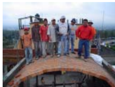
Albañiles Juanito, Napoleón, Adán, Isidro, Nacho, Benito, Emiliano y arq. Ramón, sobre bóveda durante su construcción.
