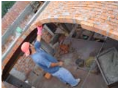
Foto 20. Colocación de ladrillo en seco. Albañil Ernesto A.
