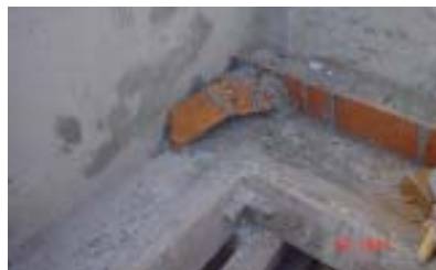
Foto 34. Colocación de ladrillo a 45°.
