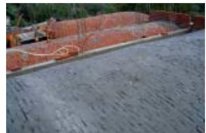
Foto 45. Bóveda con lechada.
