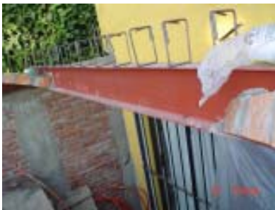
Foto 30. Trabe de acero (vigal "I" de 6"x2").
