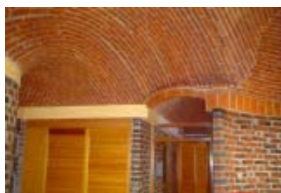
Foto 10. Casa habitación. Morelos México. Arq. Alfonso Ramírez Ponce
