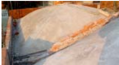
Foto 43. Bóveda aplanada para recibir impermeabilizante.
