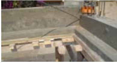
Foto 27. Trabe de hormigón armado, lista para recibir la bóveda.
