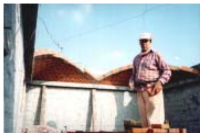
Foto 15. Intersección de pechinas realizada por el albañil Salvador Preciado. Casa de interés social. Arq. Ramón Aguirre
