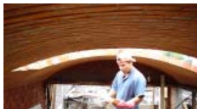
Foto 50. Interior de bóveda. Maestro Ernesto.
