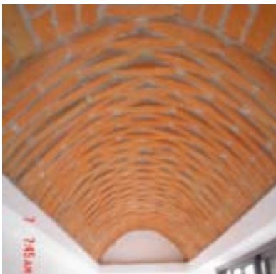
Foto 51. Bóveda de cañon con ladrillo 6x12x24. Casa habitación. Sto. Domingo Coyoacán.
