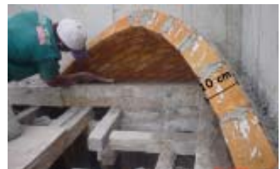
Foto 38. Espesor de la bóveda: 10 cm.
