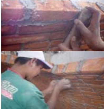
Foto 40. Limpieza de bóveda con cepillo de alambre.
