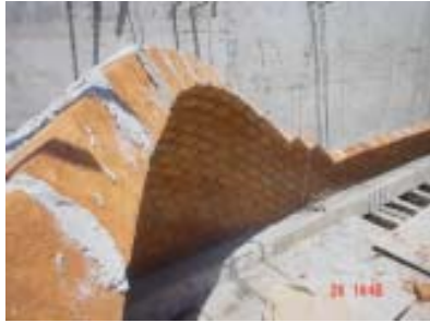
Foto 19. Detalle de arco inclinado apoyado en la hilada anterior. Universidad Hispanoamericana.
