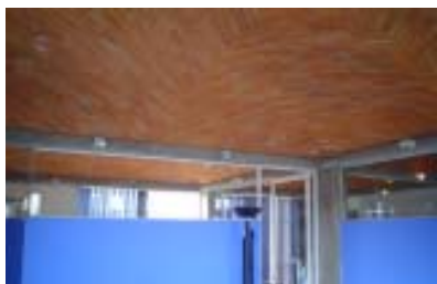
Foto 3. Vestibulo. Oficina Triángulo Diseño y Construcción, S.A de C.V. Arq. Ramón Aguirre M. Arq. Mario Vázquez
