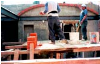
Foto 22. Andamio dentro del área a cubrir. Albañil Tomas.
