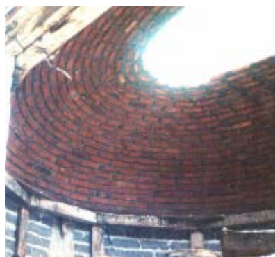
Foto 16. Cubierta circular, radio al centro. Casa habitación, La Candelaria Coyoacán. Arq. Ramón Aguirre
