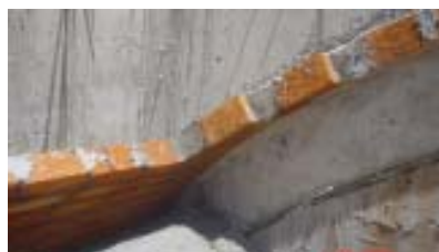
Foto 48. Detalle de bóveda de cañon hilada de ladrillo apoyada en la anterior.
