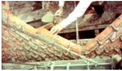
Foto 39. Intersección de dos pechinas y pegado en seco.
