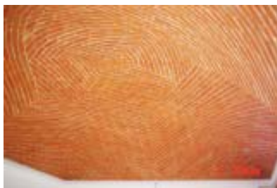
Foto 42. Vista interior de cierre de bóveda.
