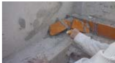
Foto 35. Segunda hilada, corte de las esquinas.
