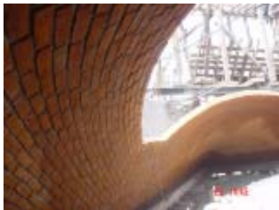
Foto 14. El tamaño del ladrillo, permite su fácil manejo. Universidad Hispanoamericana, Edo. de México. Arq. Fernando Ituarte Verduzco.
