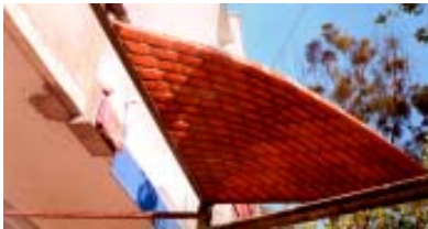
Foto 29. Trabe de acero (canal "C" de 4"x2").
