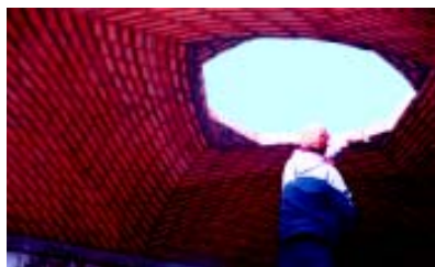
Foto 1. Cierre de bóveda, realizada por el maestro albañil Salvador Preciado. Casa habitación, Huahuchinango Puebla. Arq. Ramón Aguirre.
