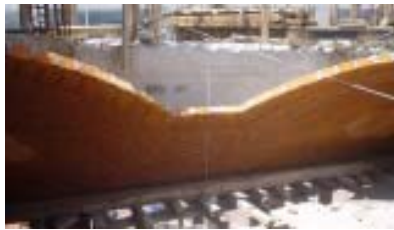
Foto 41. Intersección de dos pechinas con cierre en forma de espiral.
