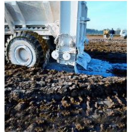
Aplicación de óxido de calcio sobre suelo arcilloso para reducir su plasticidad e incrementar los valores de resistencia a la compresión finales.
